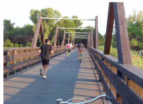
Lavori di risanamento del ponte ciclopedonale sul Salinello: chiuso il transitto
